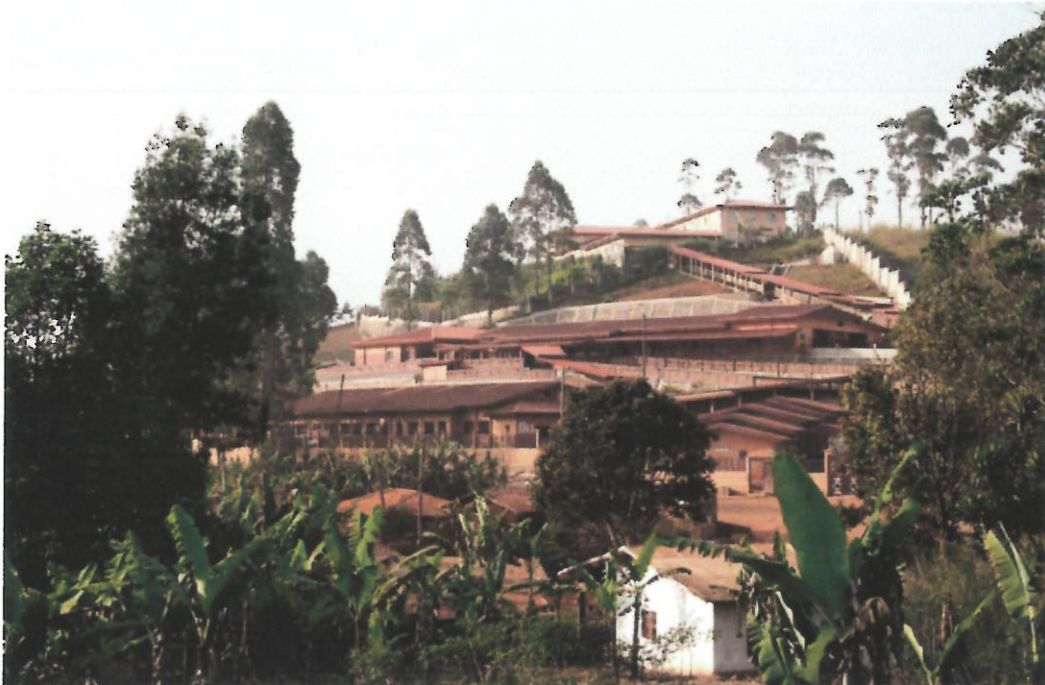
Vista del edificio del convento y el hospital construido en pabellones sobre un cerro
